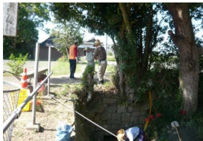
2014年10月25日、作業グループが石垣水路を浚渫した
